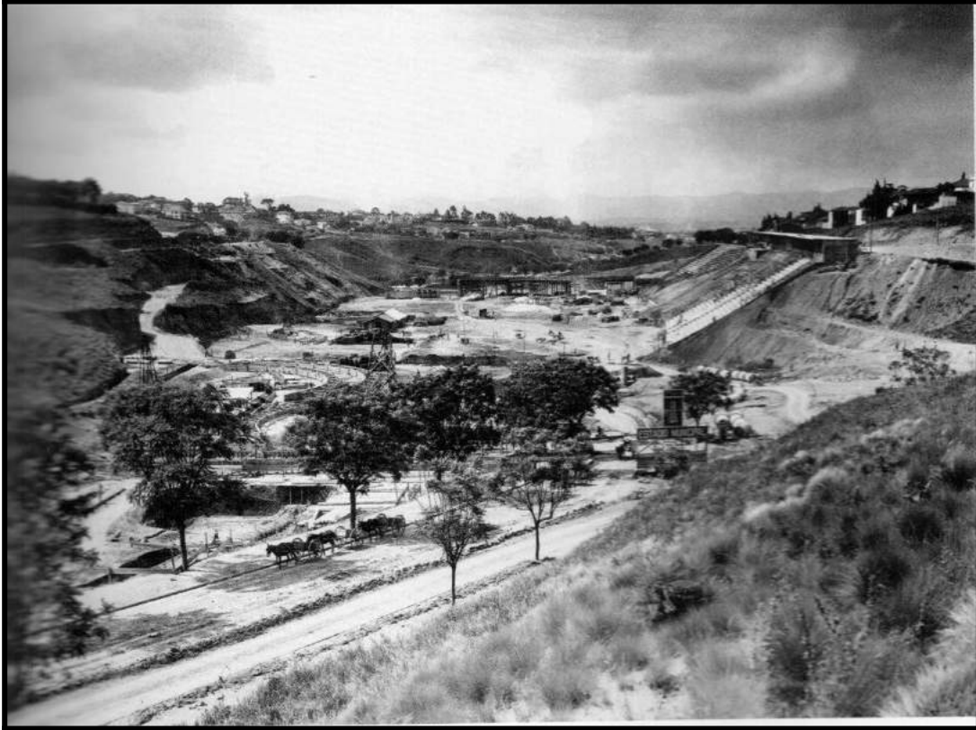
As obras em andamento, com as arribancadas sendo “acomodadas” nos flancos do vale.
