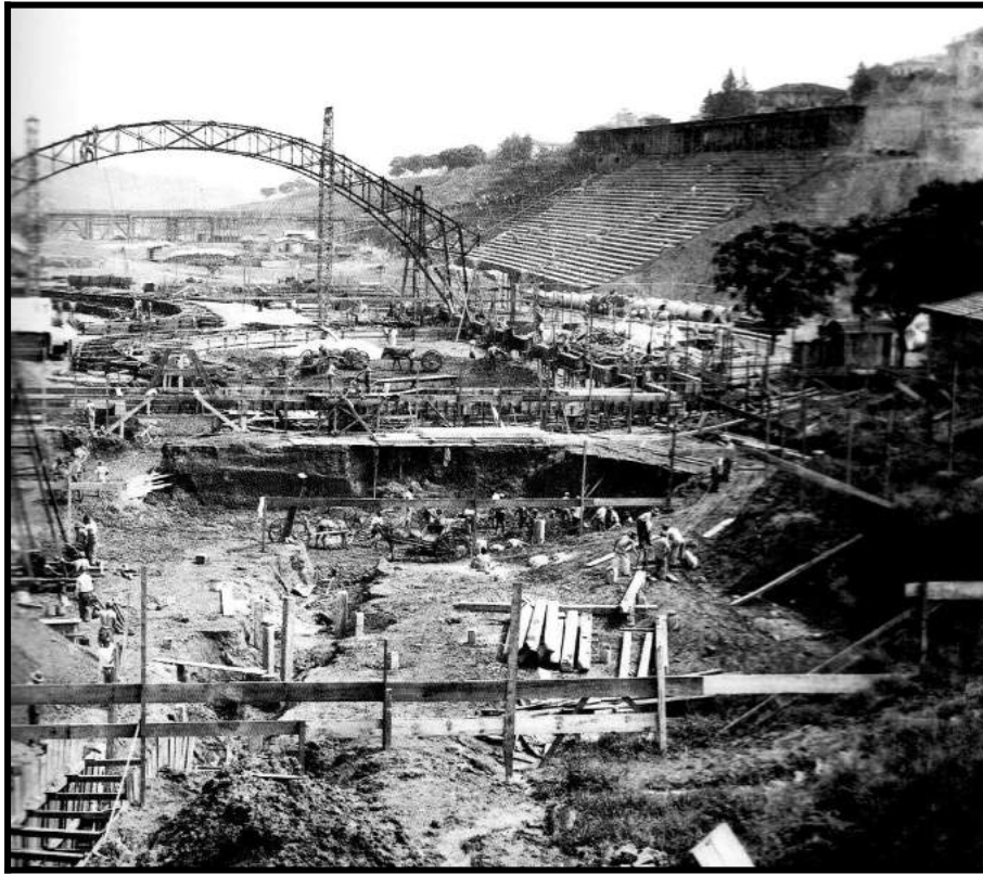
Detalhe do canteiro de obras.
