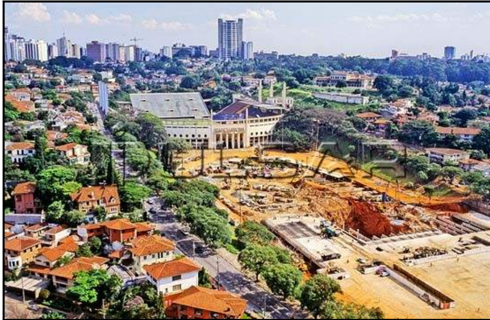
Obras do piscinão na Praça Charles Muller.
